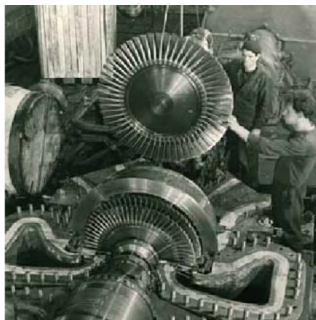
Изготовление паровой турбины
