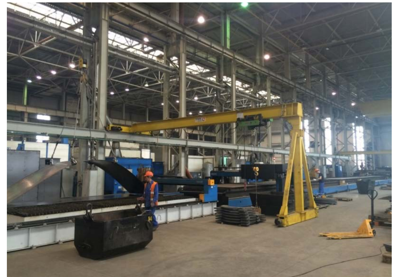
Установка газоплазменной резки с ЧПУ на сборочно-сварочном производстве Невского завода
