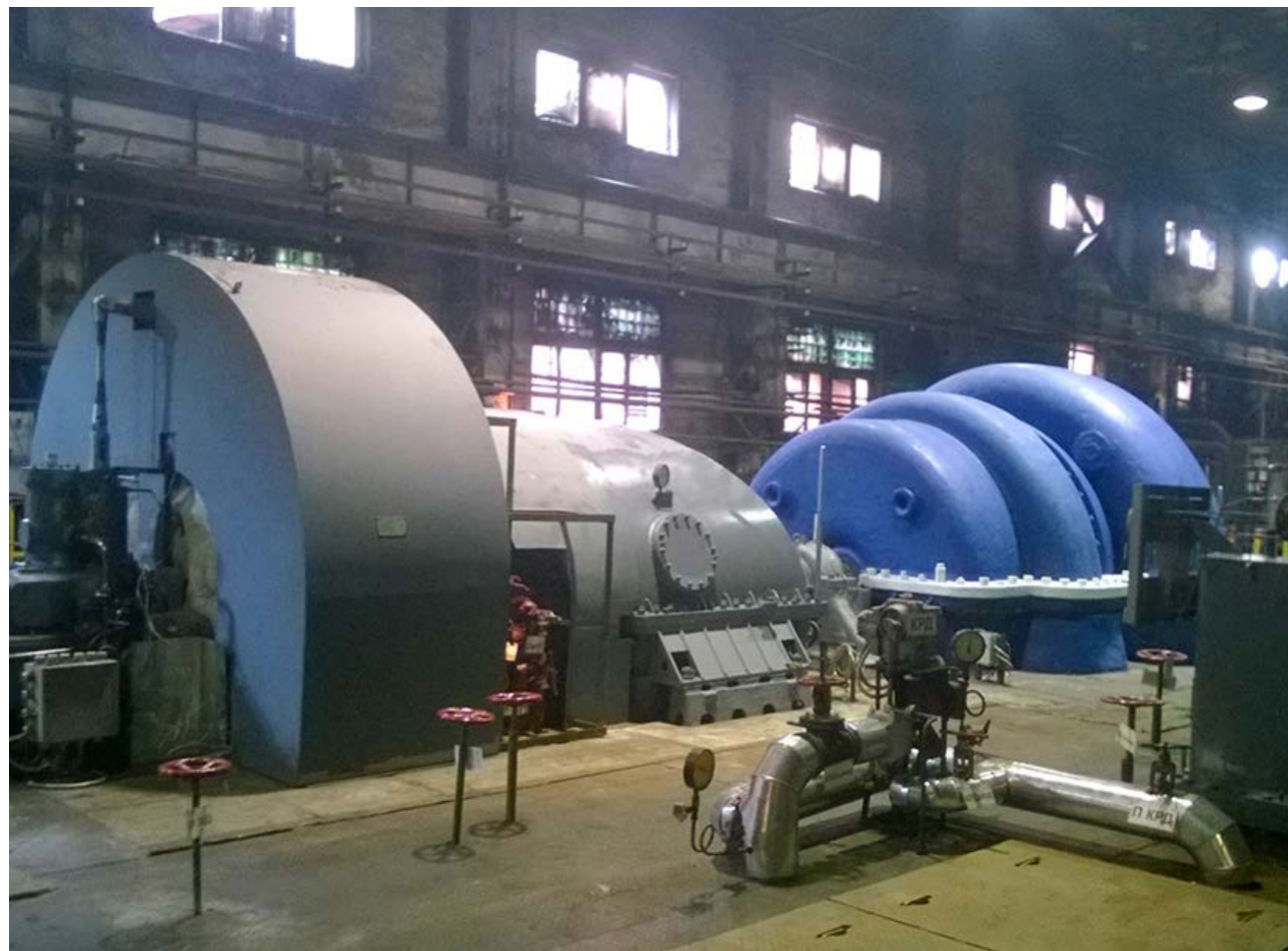
Турбокомпрессорный агрегат 5200/25 с автоматической системой контроля и управления на Магнитогорском металлургическом комбинате
