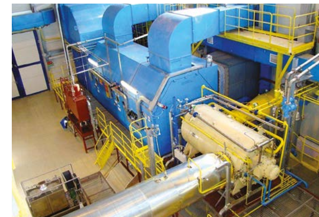
295 СПЧ на дожимной компрессорной станции Западно-Таркосалинского газового промысла ООО «Газпром добыча Ноябрьск»
